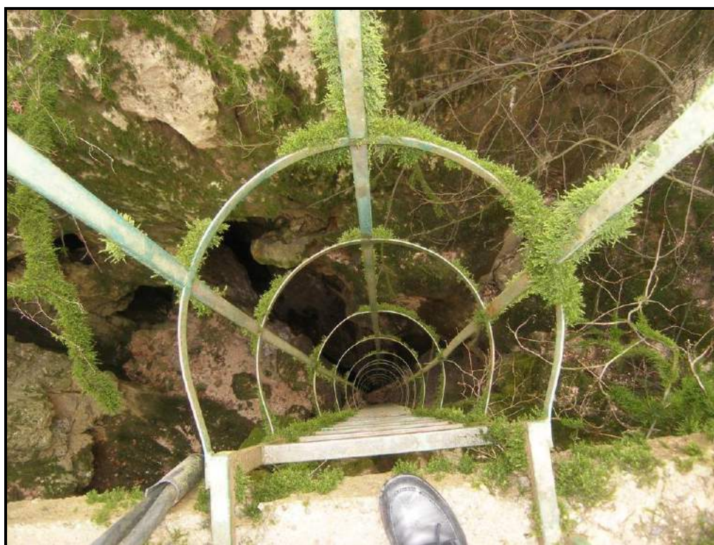
Slika 2.2.1-2. Postojeće metalne ljestve s leđnom zaštitom u estaveli Betina
